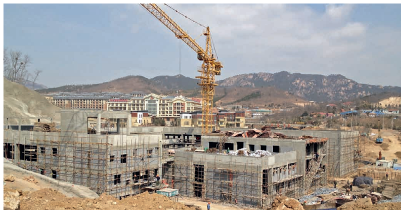
7. Baustelle VEZ, Qingdao im März 2014
