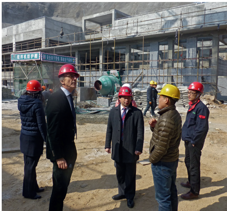
6. 半集中式供水排污处理中心(RRC)施工现场,青岛,2014年3月
