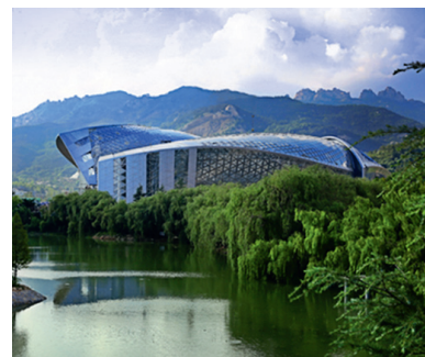
4. 半集中式供水排污处理中心
